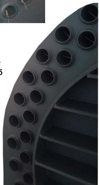
Увеличение температуры отходящих газов с котла на 20 °С снижает коэффициент полезного действия котла на более чем 1,0 %.
