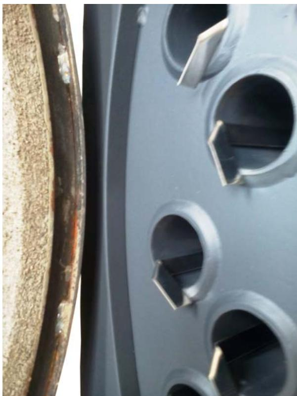
При техническом обслуживании и замене турбулизаторов рекомендуется также проверить состояние уплотнения передней двери. Негерметичное уплотнение влияет на геометрию потоков в поворотной камере дверного проема с утечками при достижении этим уплотнением критического состояния. При неравномерных потоках и распределении тепла по всем поверхностям нагрева дымогарных труб будут появляться соответствующие признаки на турбулизаторах в самых напряженных местах в виде изменения цвета, геометрии и длины.
